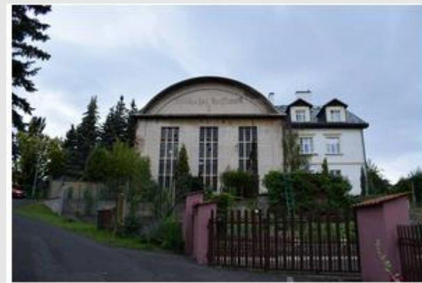
dieselová elektrárna Kadaň
