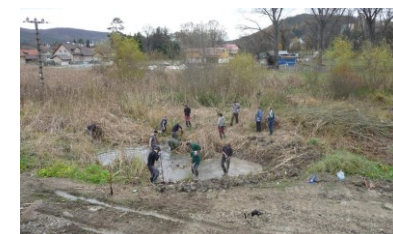
obnova tůní - revitalizace
